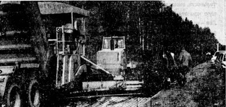
Укладка нового асфальтового слоя. Шефмонтаж фирмы ВИРТГЕН
