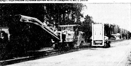
Снятие старого асфальтового покрытия и внутренних напряжений в бетонных плитах. Шефмонтаж ведёт фирма ВИРТГЕН
