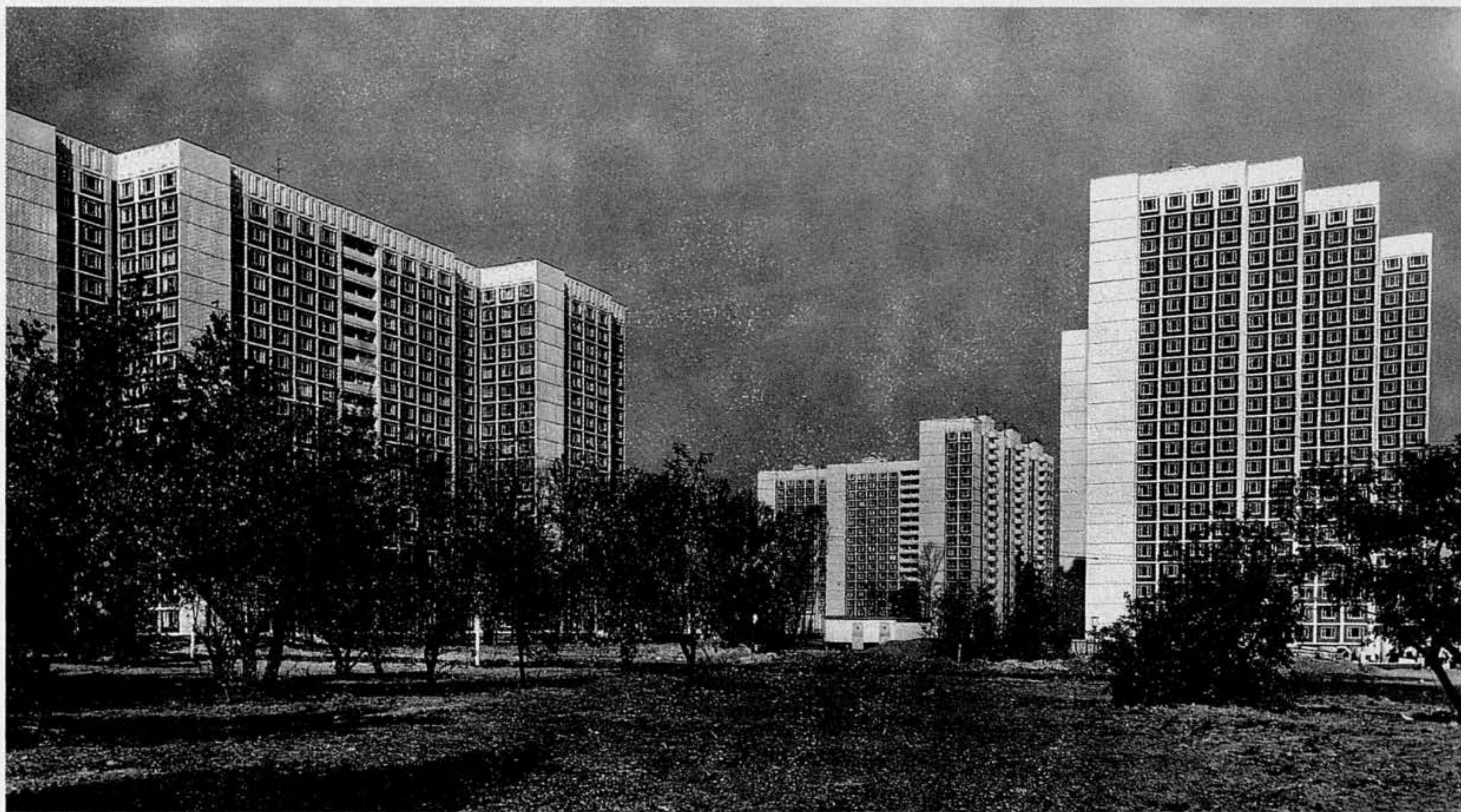
Застройка жилого района Воронцово в Москве жилыми домами по системе КОПЭ
